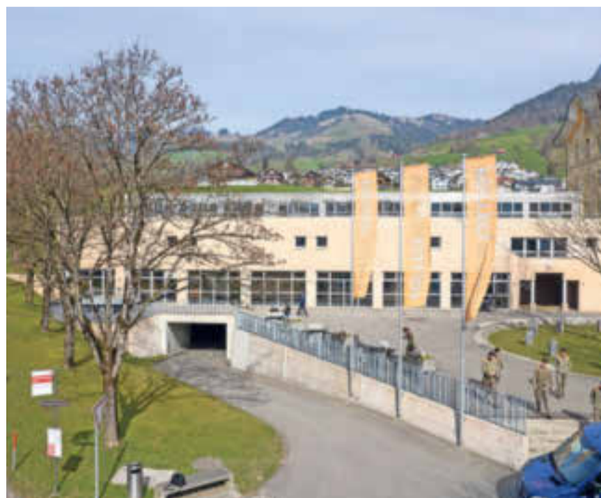
Stimmt der Kantonsrat zu, kann die 40 Jahre alte Kollegi-Turnhalle saniert und er-weitert werden. Bild: Erhard Gick
