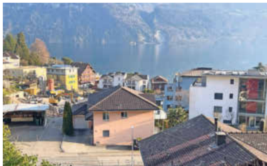
Die Baustelle in Gersau, wo die Abbrucharbeiten laufen.
